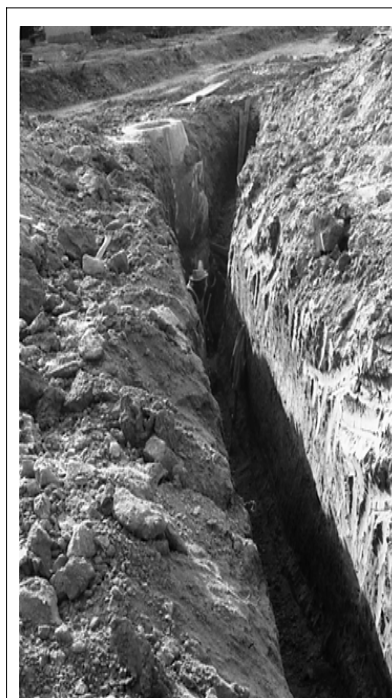
Tranchée pour le tout à l'égout....
