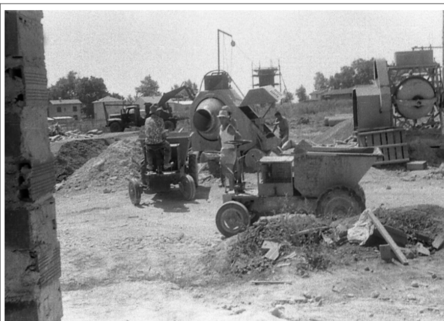
Bétonnières et Dumper en action, le travail s'accélère ...
