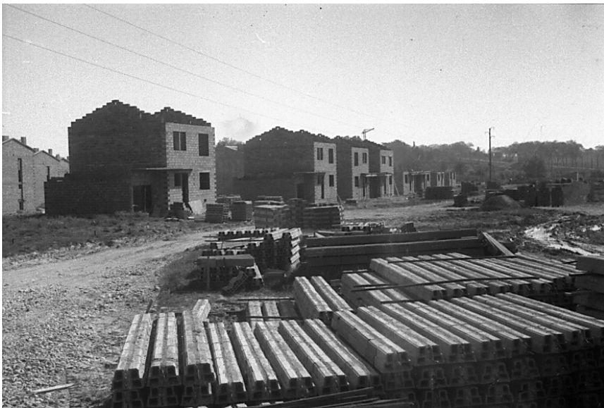
Stockage de poutres de hourdis près du hangar
