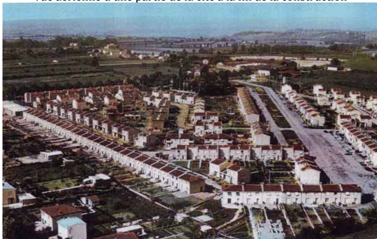
Vue aérienne d'une partie de la cité à la fin de la construction
