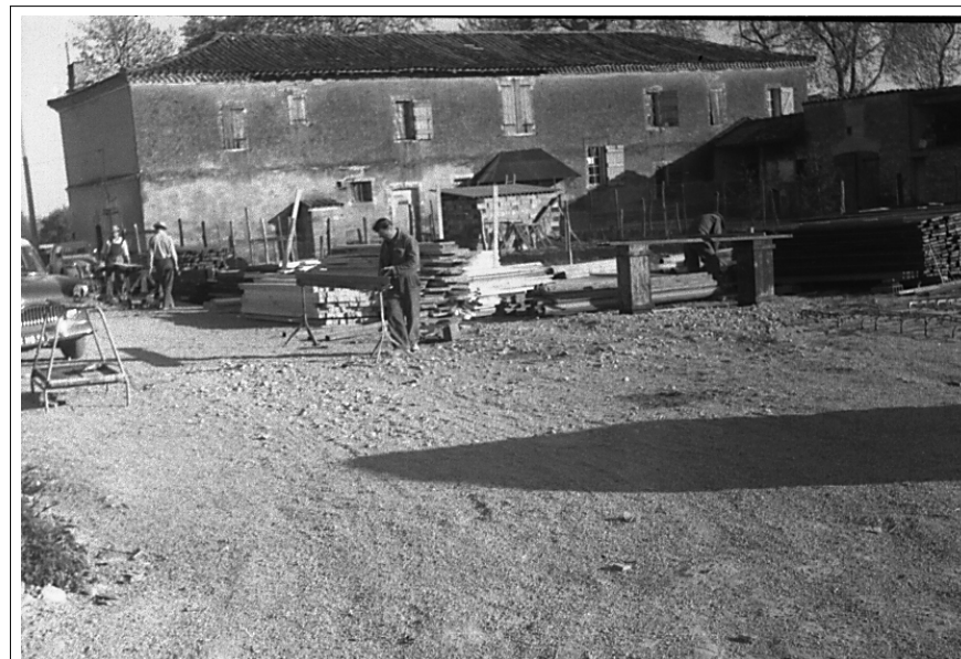
A proximité du réfectoire, traitement des bois de charpente au carbonil
